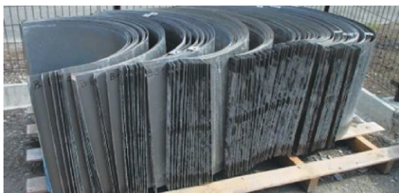
搬出事例：約50セットの使用済み型枠
