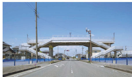
同上／A工区
