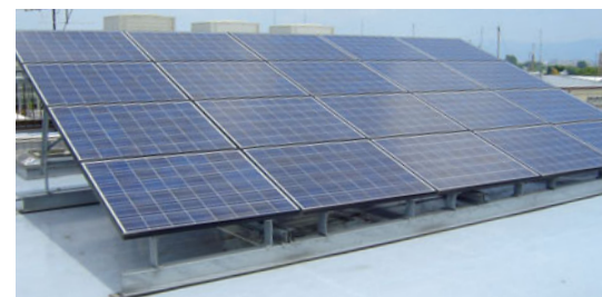
太陽光パネル
