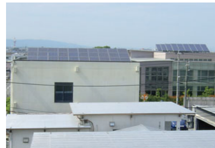
屋上に設置したソーラーパネル
