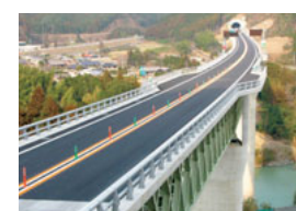
5 防護柵・高欄
