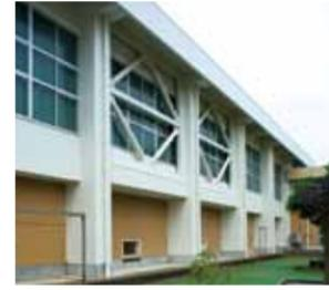
耐震補強工法ブレース
