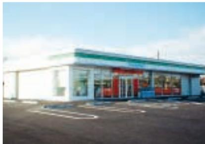
舗の建設および解体の工期を大幅に短縮・簡便化した工法です。また、組み合わせにより、各FC店の形状・規模の違いに対応できる製品(部材)構成となっております。
