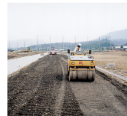
路盤材として施工されます。
