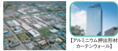
15 新日軽(株) 船橋製造所
