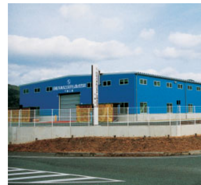
日軽パネルシステム(株) 下関工場
