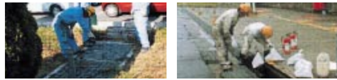
緊急時の油漏れ処置訓練(幸田工場)
