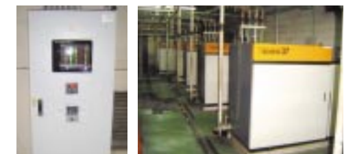
台数自動制御盤 コンプレッサー室内全景
