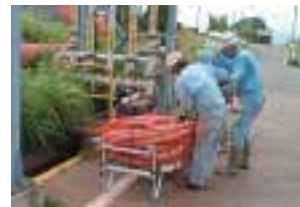
薬液混入排水回収訓練（清水工場）
