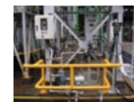
排水監視機器
