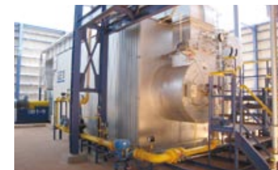
ガスボイラー
