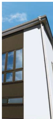
ソーラースパンドレル 施工例
