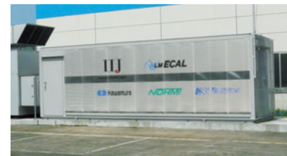
モジュール型データセンター (株)エヌ・エル・エム・エカル
