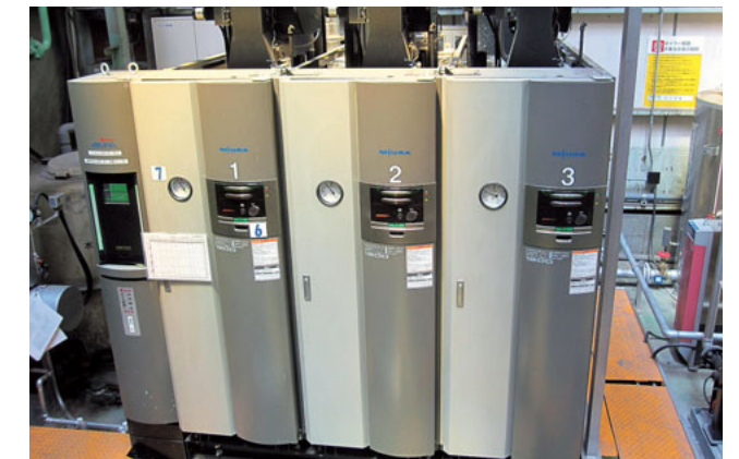
皮膜工程ボイラー[理研軽金属工業(株)]
