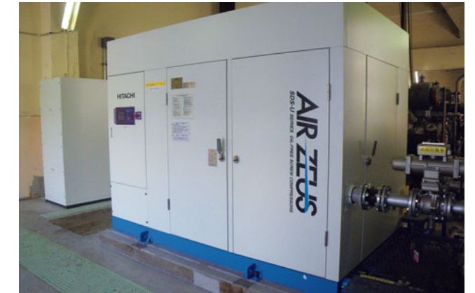
大型析出槽空気攪拌用コンプレッサー[日本軽金属(株)清水工場]
