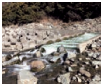
十島堰堤魚道
