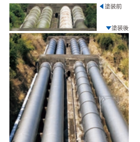
ステンレスフレーク入り塗料を使って補修された日本軽金属(株)蒲原製造所第二発電所用水圧鉄管の施工前と施工後の様子 水圧鉄管としては珍しく海岸線からの距離はわずか750m(鉄管中央部)であり、また海風をさえぎる建物などもないため、傷みやすくメンテナンスに苦労していました。
