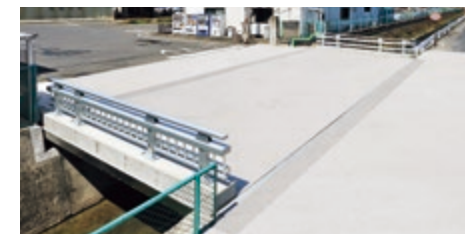
アルミ床版を使用した橋(日本軽金属(株)蒲原製造所内) この橋は出荷や納品の大型車両が多く通行しています。
