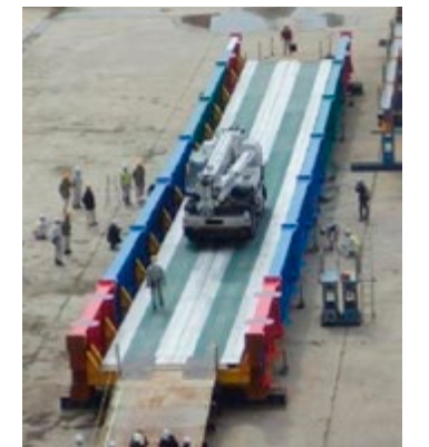
緊急仮設橋(国土交通省近畿地方整備局)
