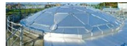
㈱住軽日軽エンジニアリングが施工した相模原浄水場の蓋
