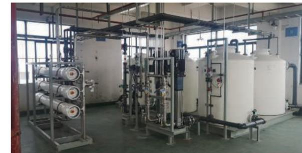
東陽精密機器の逆浸透膜浄水装置
