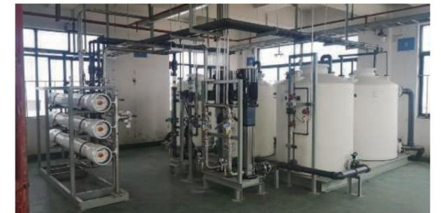
東陽精密機器の逆浸透膜浄水装置
