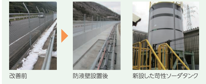
改善前 防液壁設置後 新設した奇性ソーダタンク
