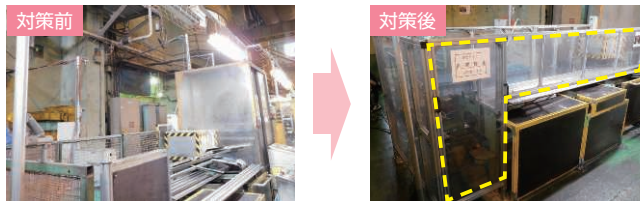
日本軽金属(株)蒲原熱交製品工場の改善例 切断機周辺の安全柵を追加し、安全装置を設置した
