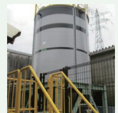
新設した苛性ソーダタンク
