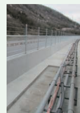
防液壁設置後
