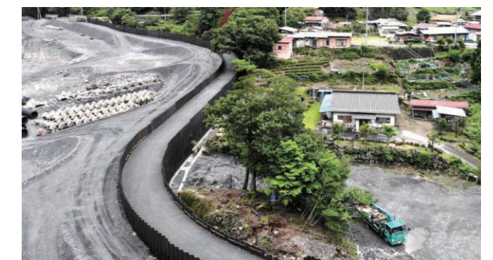
構築途中の仮設堤防の様子(2020年7月撮影)
