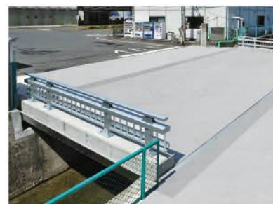
アルミ製道路橋床版を利用した橋
