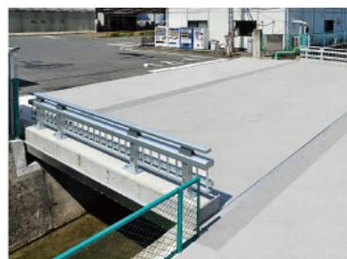
アルミ製道路橋床版を利用した橋
