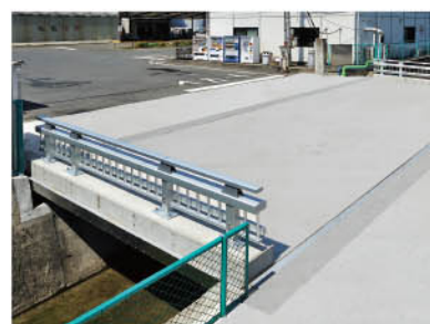
アルミ製道路橋床版を利用した橋
