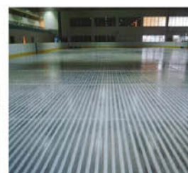
スケートリンク施工事例
