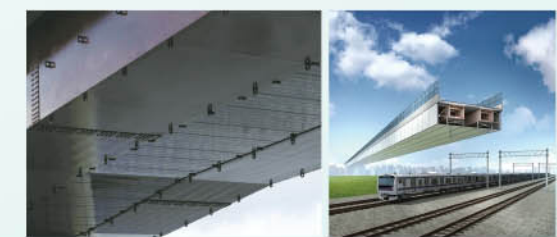
岩松川橋上部工事
