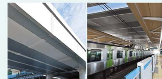
高輪ゲートウェイ駅東側連絡通路桁下設置例
