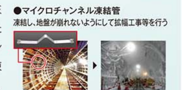
掘削現場の内壁に貼付け 掘削現場を凍結
