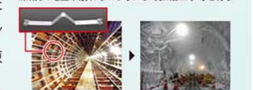
掘削現場の内壁に貼付け 掘削現場を凍結
