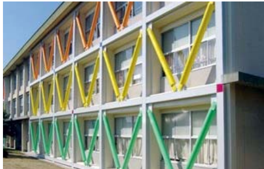
耐震補強ブレース (株)住軽日軽エンジニアリング
