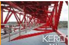
11 住み続けられるまちづくりを 橋梁検査路
